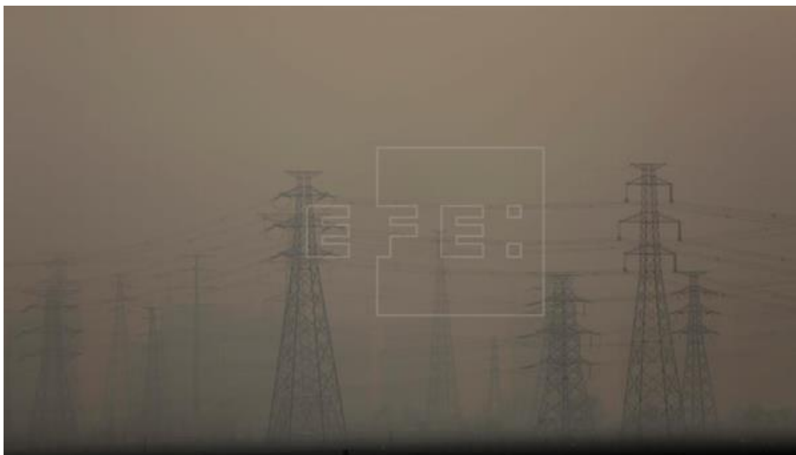
La bruma envuelve unas torres de electricidad. EFE/Archivo
