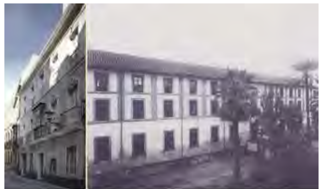
Fachada de la línea interior reformada
