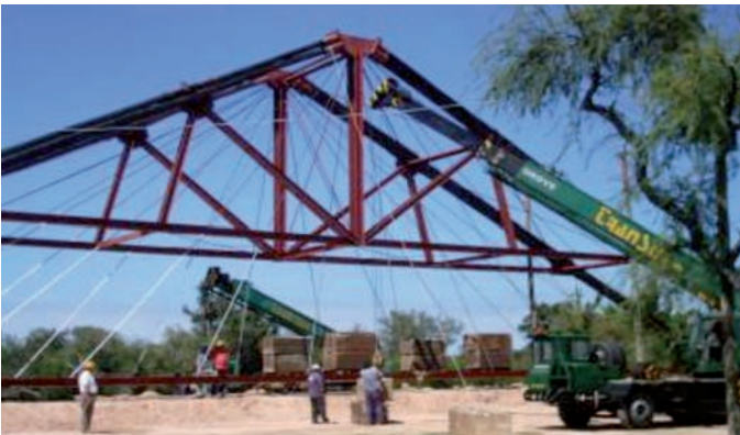
Figura 8.10. Ensayo del puente en tierra, con bloques de hormigón, con una carga total equivalente al peso del tablero y máxima carga de vehículos.
