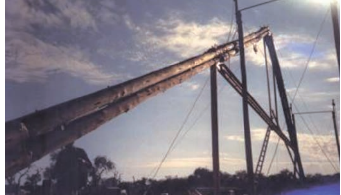
Figura 8.9. Comenzando el montaje.
