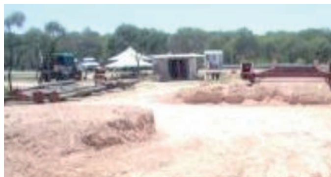
Figura 8.7. Depósito en obrador de puntales formados por 4 rollizos.
