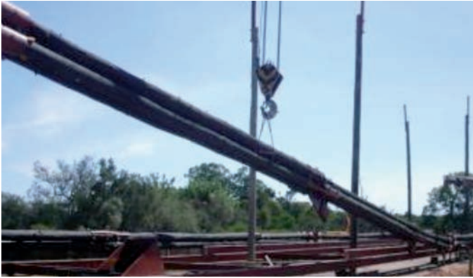
Figura 8.8. Levantando los puntales para comenzar el montaje en el obrador.
