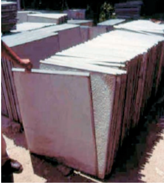
Figura 9.2. Manejo manual de pequeños paneles de hormigón de 3 cm de espesor, del sistema venezolano ‘Sancocho’ para la autoconstrucción de viviendas aisladas de una planta.
