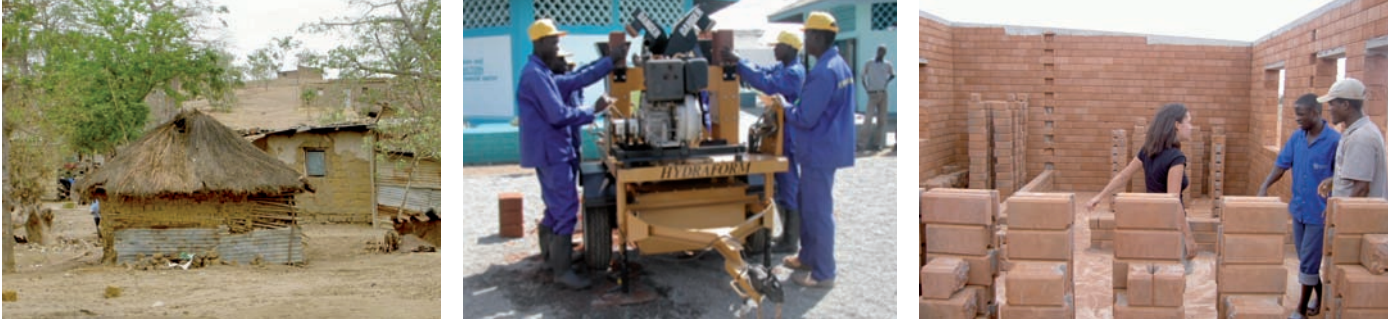
Figura 9.14. - 9.15. - 9.16. Tres aspectos de la construcción de viviendas rurales aisladas en Funda (Angola) 7 . Fuente: J. Salas.
