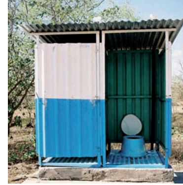
Figura 9.24. Letrina elevada en un asentamiento campesino nicaragüense (J. Salas).
