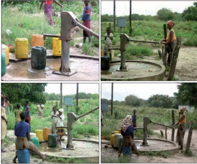
Figura 9.37. Bombas de cilindro manuales. Los pozos están situados en lugares estratégicos: en la escuela, en el vivero, en el mercado y en el perímetro del asentamiento, para abastecer también a poblaciones vecinas. Previamente se habían realizado estudios geofísicos e hidrológicos en la parcela (P. Palomino y J. Salas).
