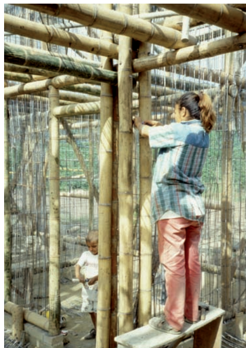
Figura 9.27. Soluciones de vivienda con la estructura en guadua en la región del Quindío, Colombia (B. Gesto).
