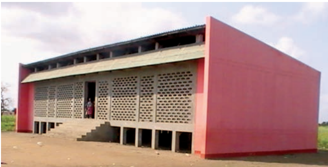
Figura 9.25. Propuesta de UN Hábitat de escuela-refugio para las aldeas afectadas anualmente por el desbordamiento del río Limpopo, Mozambique (B.Gesto).
