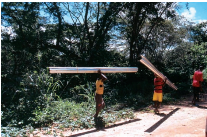
Figura 9.5. Transporte manual, por los propios autoconstructores, de planchas de zinc para cubierta desde un mercado dominical de Assango (Angola) a una comunidad aislada (J. Salas).
